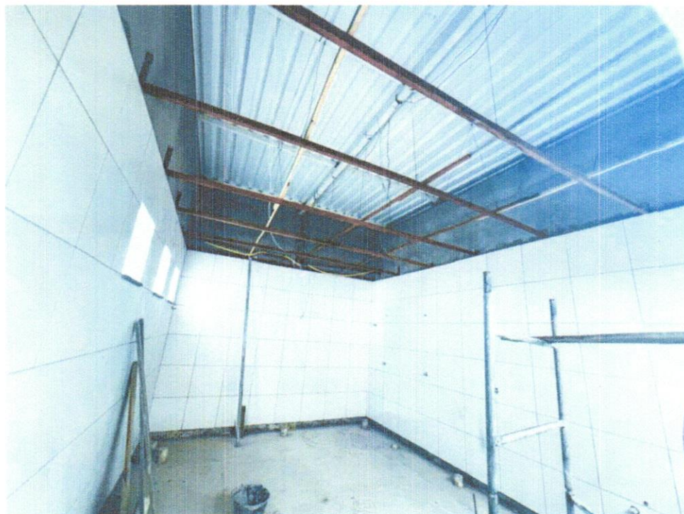
FOTO 24 – INSTALAÇÃO DE REVESTIMENTO CERÂMICO BRANCO APLICADO COM ARGAMASSA INDUSTRIALIZADA AC-II, REJUNTADO, EXCLUSIVE REGULARIZAÇÃO
