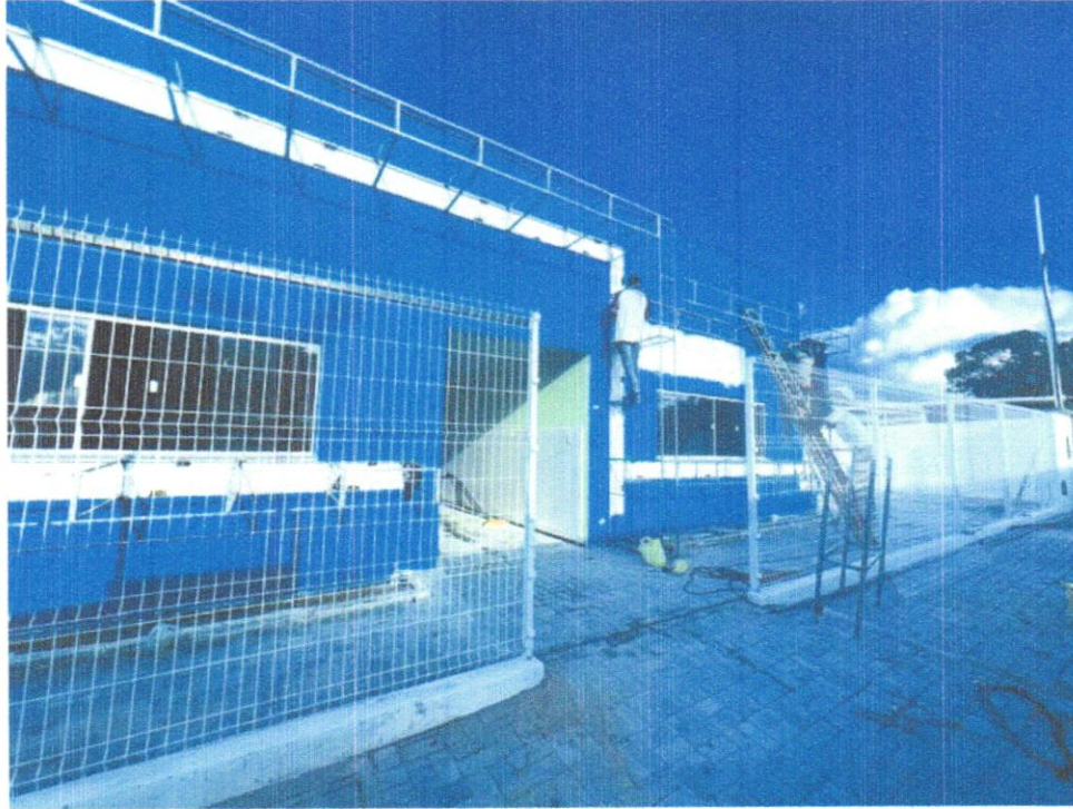
FOTO 16 – TELHAMENTO COM TELHA METÁLICA TERMOACÚSTICA
