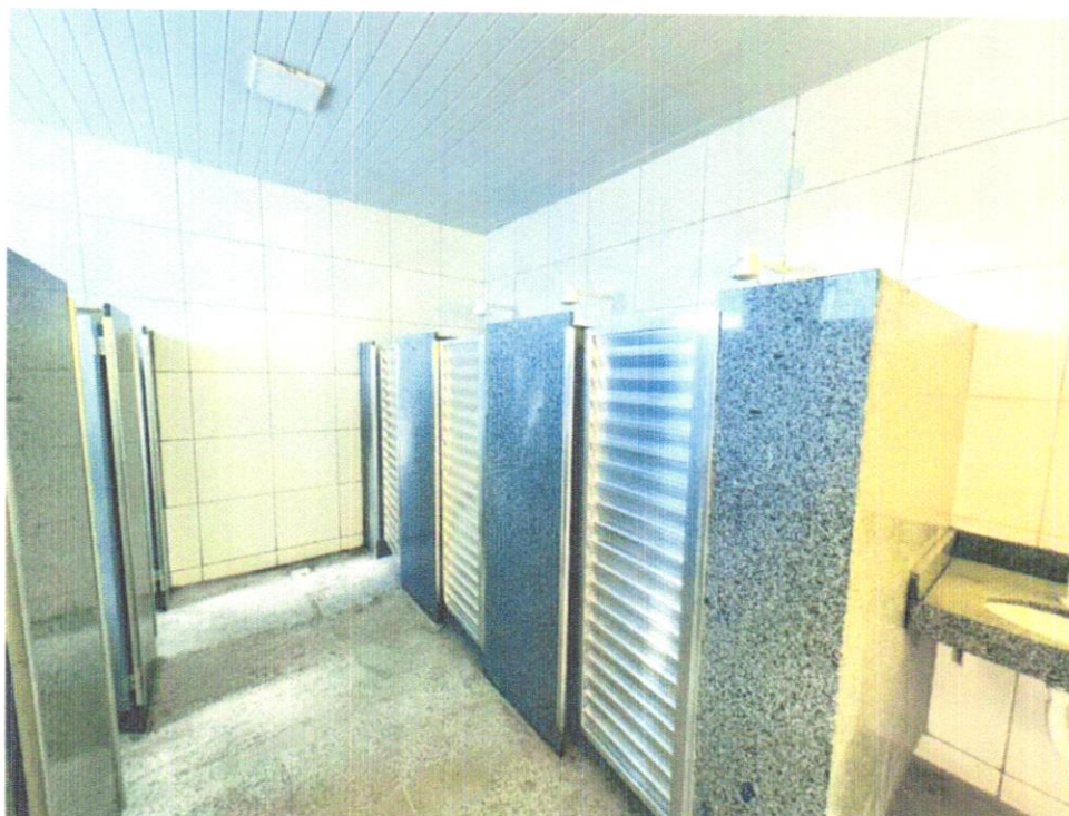
FOTO 04 – INSTALAÇÃO PORTA DE ABRIR EM ALUMÍNIO TIPO VENEZIANA, ACABAMENTO ANODIZADO NATURAL, SEM GUARNIÇÃO/ALIZAR/VISTA
