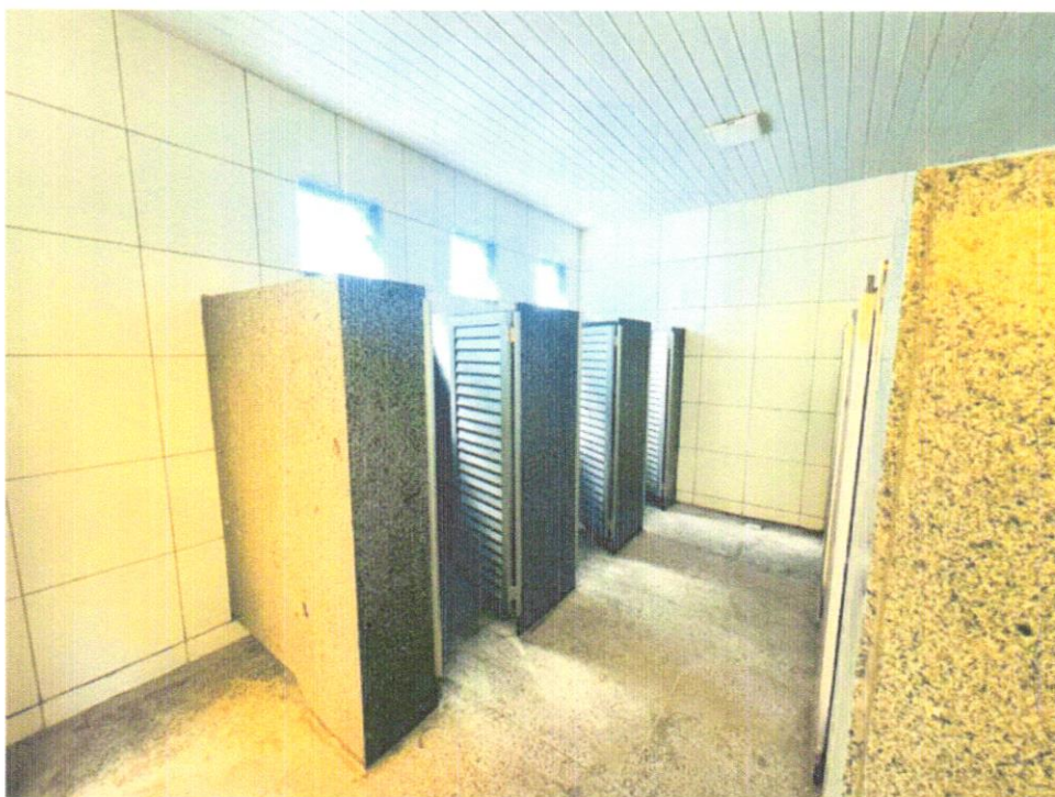
FOTO 04 – INSTALAÇÃO PORTA DE ABRIR EM ALUMÍNIO TIPO VENEZIANA, ACABAMENTO ANODIZADO NATURAL, SEM GUARNIÇÃO/ALIZAR/VISTA
