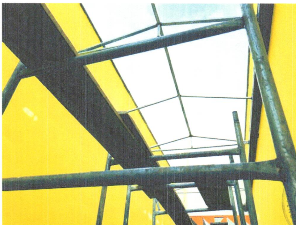
FOTO 20 – INSTALAÇÃO DE CHAPAS DE POLICARBONATO
