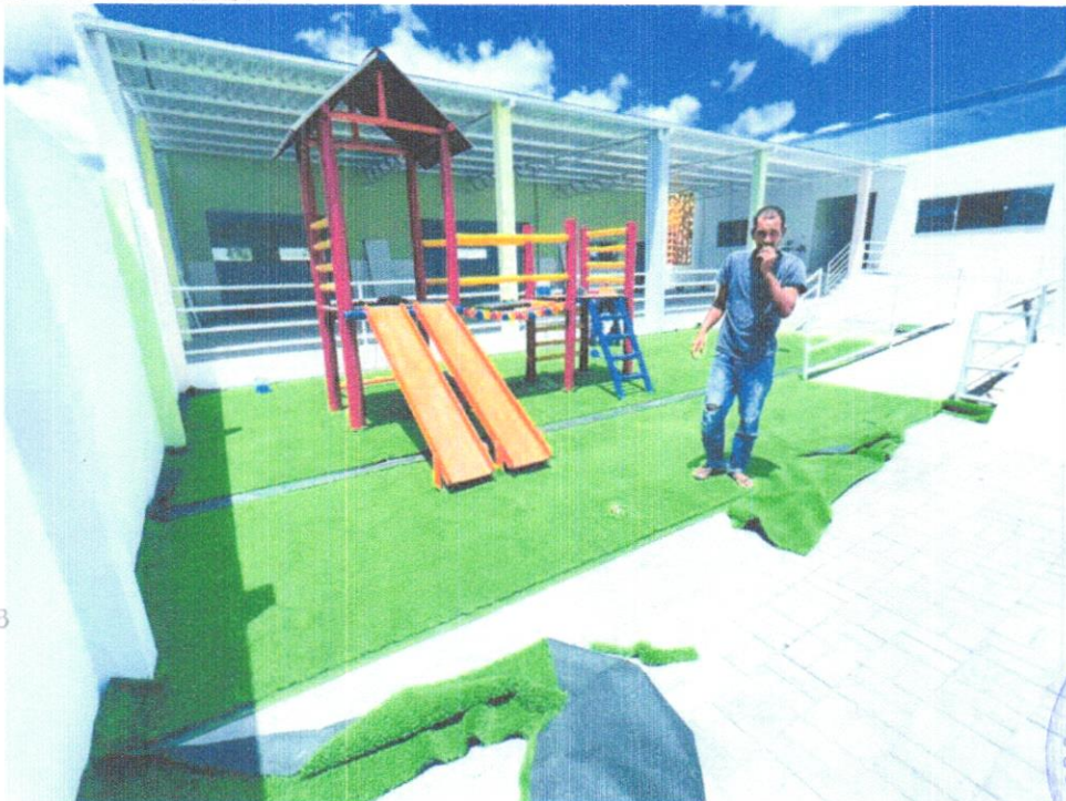
FOTO 58 – FORNECIMENTO E INSTALAÇÃO DE GRAMA SINTÉTICA 42MM, ALTA DURABILIDADE, COR VERDE, PROTEÇÃO RAIOS UV E LUZ SOLAR, INCLUSO COLA, TYPE, AREIA TRATADA, BORRACHA E MÃO DE OBRA ESPECIALIZADA
