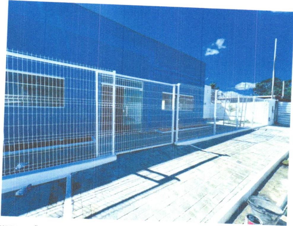
FOTO 12 – INSTALAÇÃO GRADIL TIPO MORLAN
