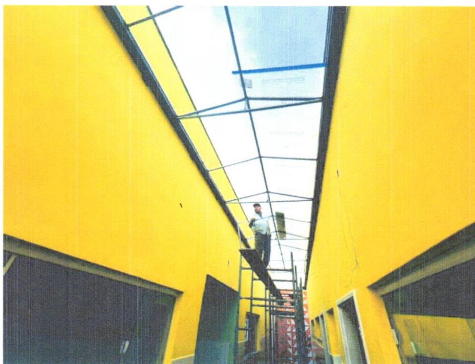
FOTO 20 – INSTALAÇÃO DE CHAPAS DE POLICARBONATO
