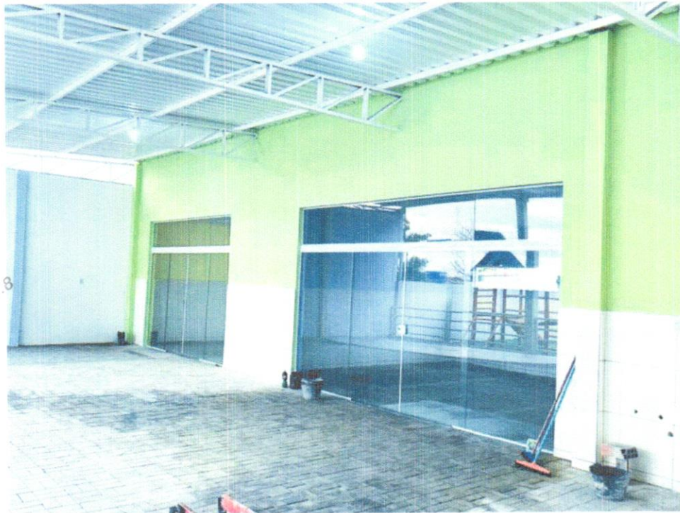
FOTO 16 – TELHAMENTO COM TELHA METÁLICA TERMOACÚSTICA
