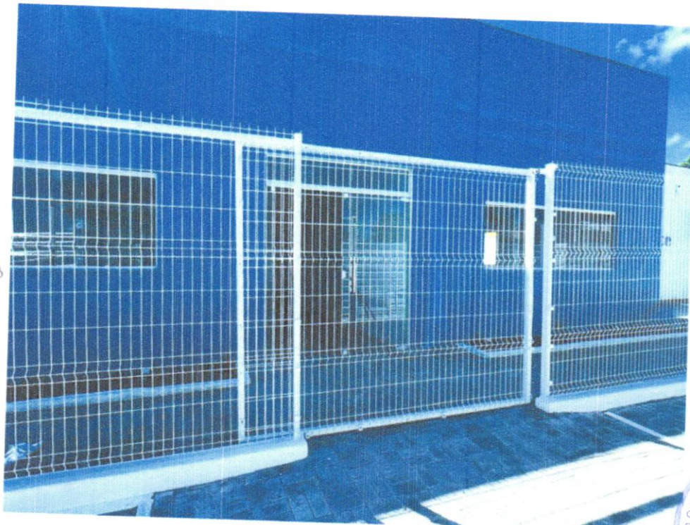
FOTO 12 – INSTALAÇÃO GRADIL TIPO MORLAN
