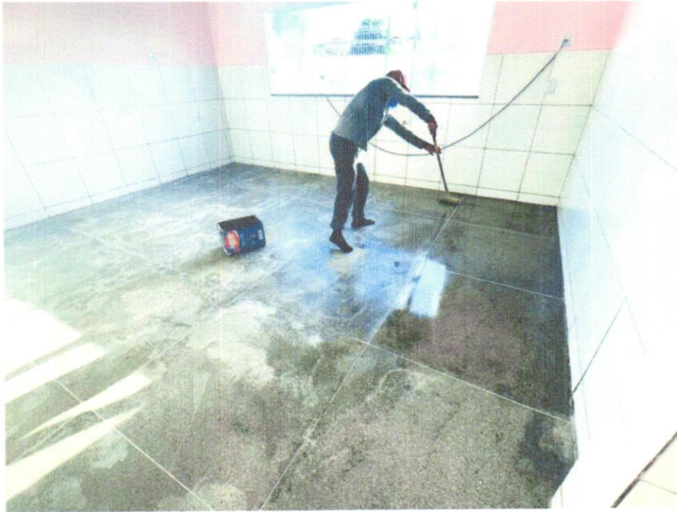
FOTO 27 – APLICAÇÃO DE PISO ALTA RESISTÊNCIA, COR CINZA, APLICADO COM JUNTAS E COM APLICAÇÃO DE POLIMENTO
