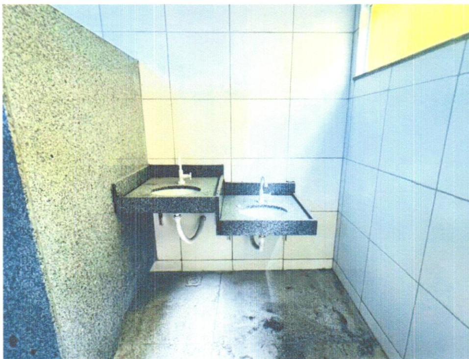
FOTO 42 – INSTALAÇÃO DE LAVATÓRIO COM BANCADA EM GRANITO CINZA ANDORINHA COM DUAS CUBAS DE EMBUTIR DE LOUÇA, SIFÃO CROMADO, VÁLVULA CROMADA E TORNEIRA CROMADA.
