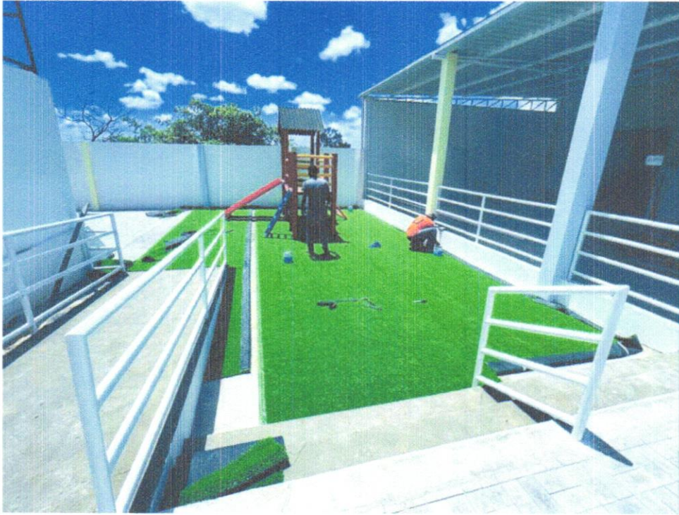
FOTO 58 – FORNECIMENTO E INSTALAÇÃO DE GRAMA SINTÉTICA 42MM, ALTA DURABILIDADE, COR VERDE, PROTEÇÃO RAIOS UV E LUZ SOLAR, INCLUSO COLA, TYPE, AREIA TRATADA, BORRACHA E MÃO DE OBRA ESPECIALIZADA
