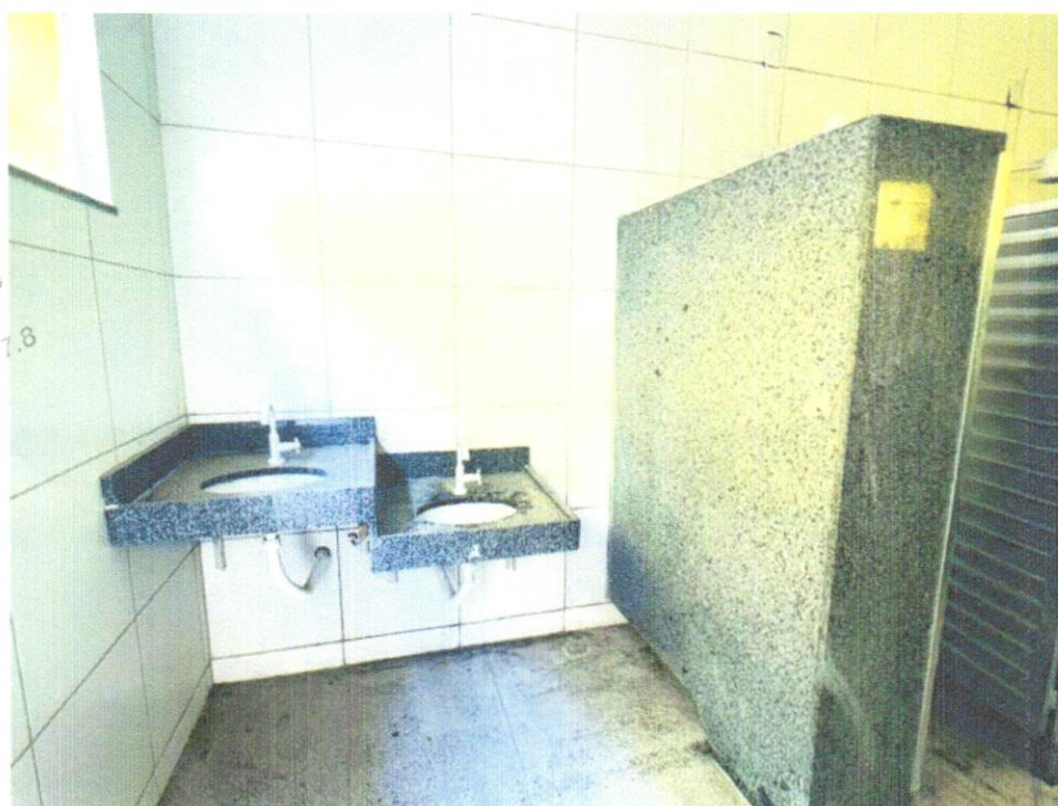
FOTO 42 – INSTALAÇÃO DE LAVATÓRIO COM BANCADA EM GRANITO CINZA ANDORINHA COM DUAS CUBAS DE EMBUTIR DE LOUÇA, SIFÃO CROMADO, VÁLVULA CROMADA E TORNEIRA CROMADA.
