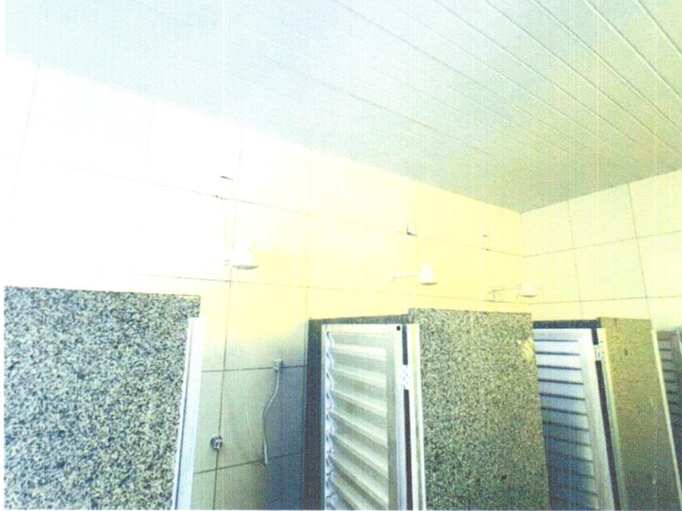
FOTO 46 – INSTALAÇÃO DE CHUVEIRO ELÉTRICO COMUM CORPO PLÁSTICO DO TIPO DUCHA
