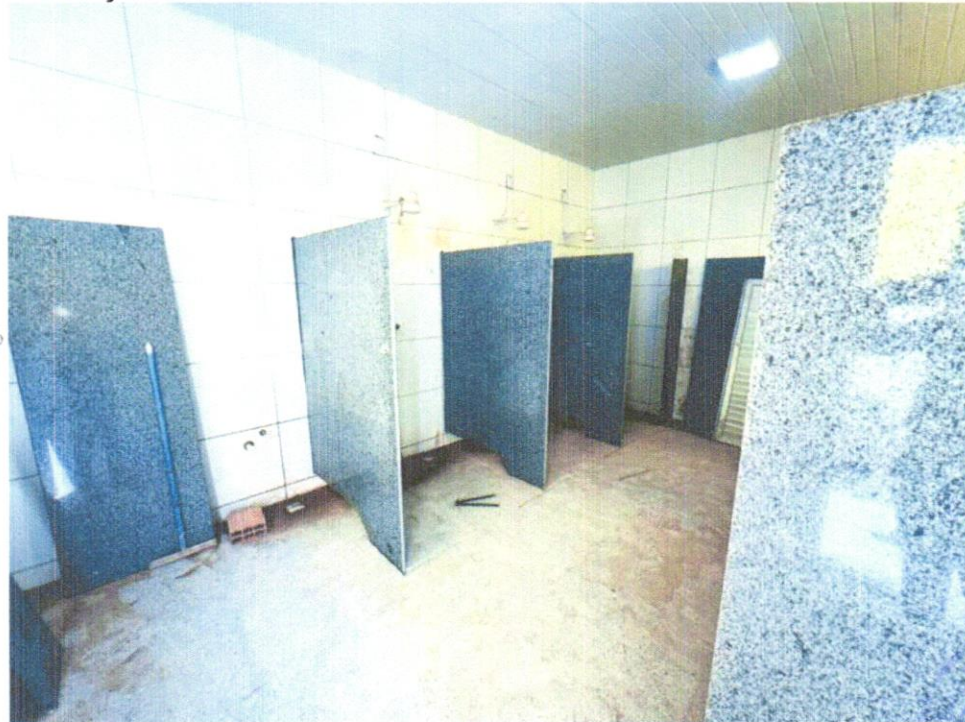
FOTO 34– INSTALAÇÃO DE DIVISÓRIAS EM GRANITO CINZA PARA MICTÓRIOS PÓLDOS
