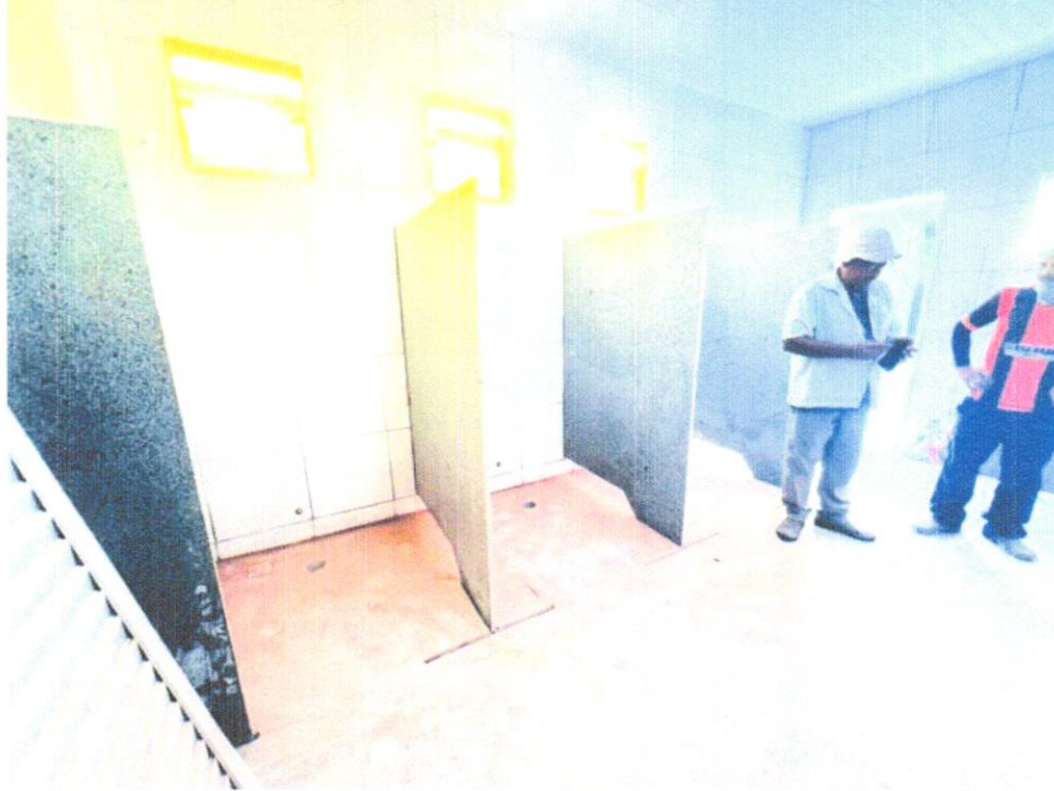
FOTO 34– INSTALAÇÃO DE DIVISÓRIAS EM GRANITO CINZA PARA MICTÓRIOS PÓLDOS
