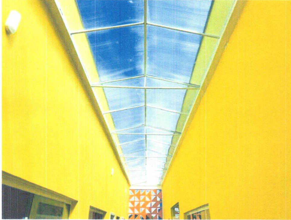
FOTO 22- INSTALAÇÃO DE CHAPAS DE POLICARBONATO
