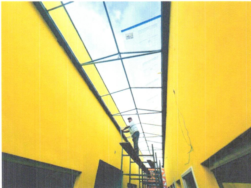
FOTO 18 – INSTALAÇÃO DE CHAPAS DE POLICARBONATO
