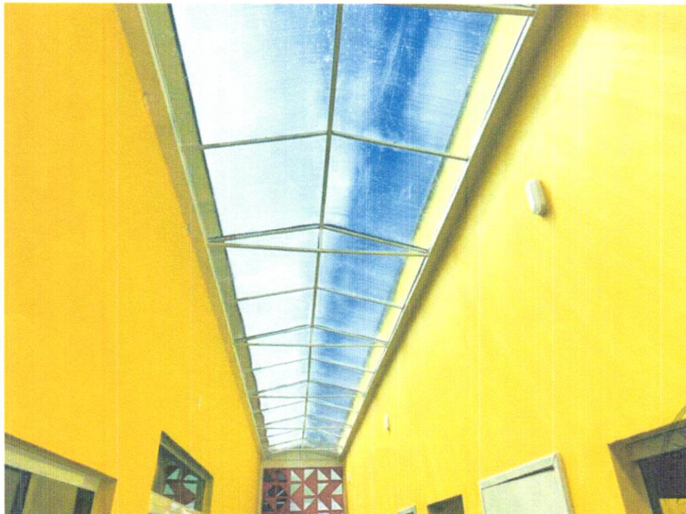
FOTO 22- INSTALAÇÃO DE CHAPAS DE POLICARBONATO
