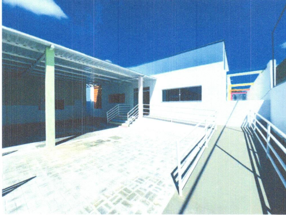
FOTO 50 – EXECUÇÃO DE RAMPA COM CONCRETO MOLDADO IN LOCO, FEITO EM OBRA, ACABAMENTO CONVENCIONAL, ESPESSURA 6 CM, ARMADO.
