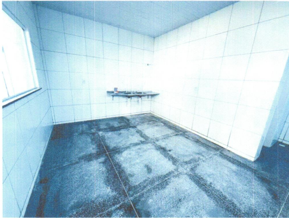
FOTO 24 – INSTALAÇÃO DE REVESTIMENTO CERÂMICO BRANCO APLICADO COM ARGAMASSA INDUSTRIALIZADA AC-II, REJUNTADO, EXCLUSIVE REGULARIZAÇÃO
