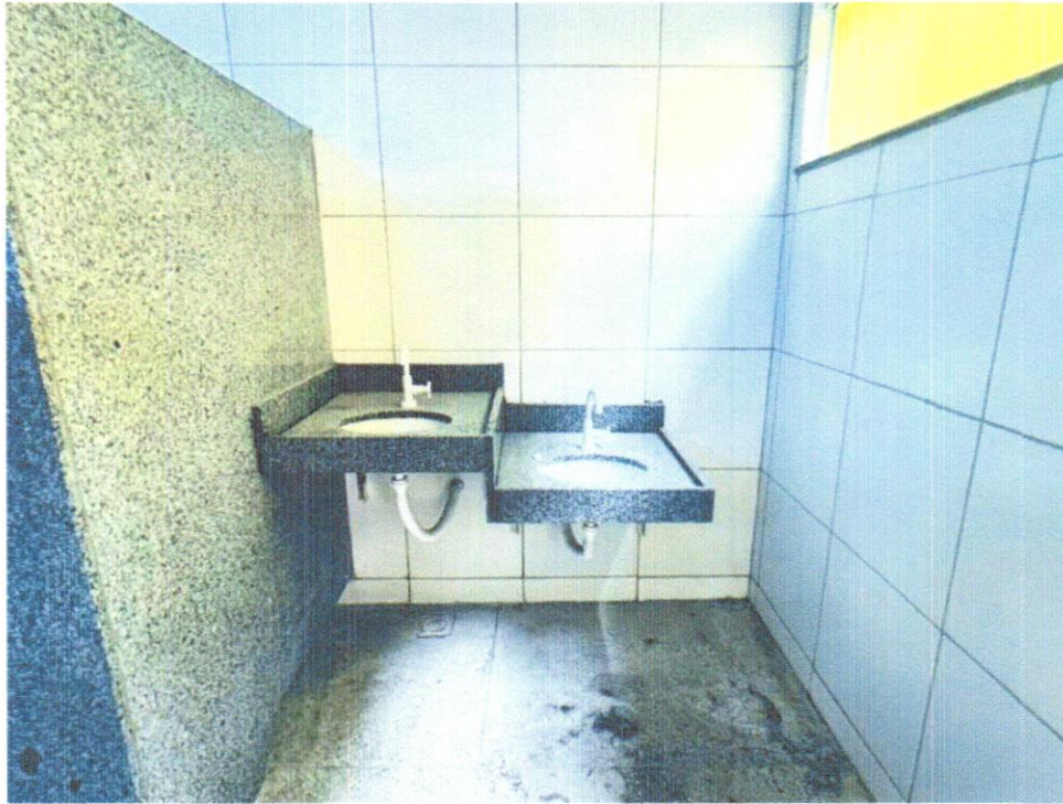
FOTO 44 – INSTALAÇÃO DE LAVATÓRIO COM BANCADA EM GRANITO CINZA ANDORINHA COM DUAS CUBAS DE EMBUTIR DE LOUÇA, SIFÃO CROMADO, VÁLVULA CROMADA E TORNEIRA CROMADA.
