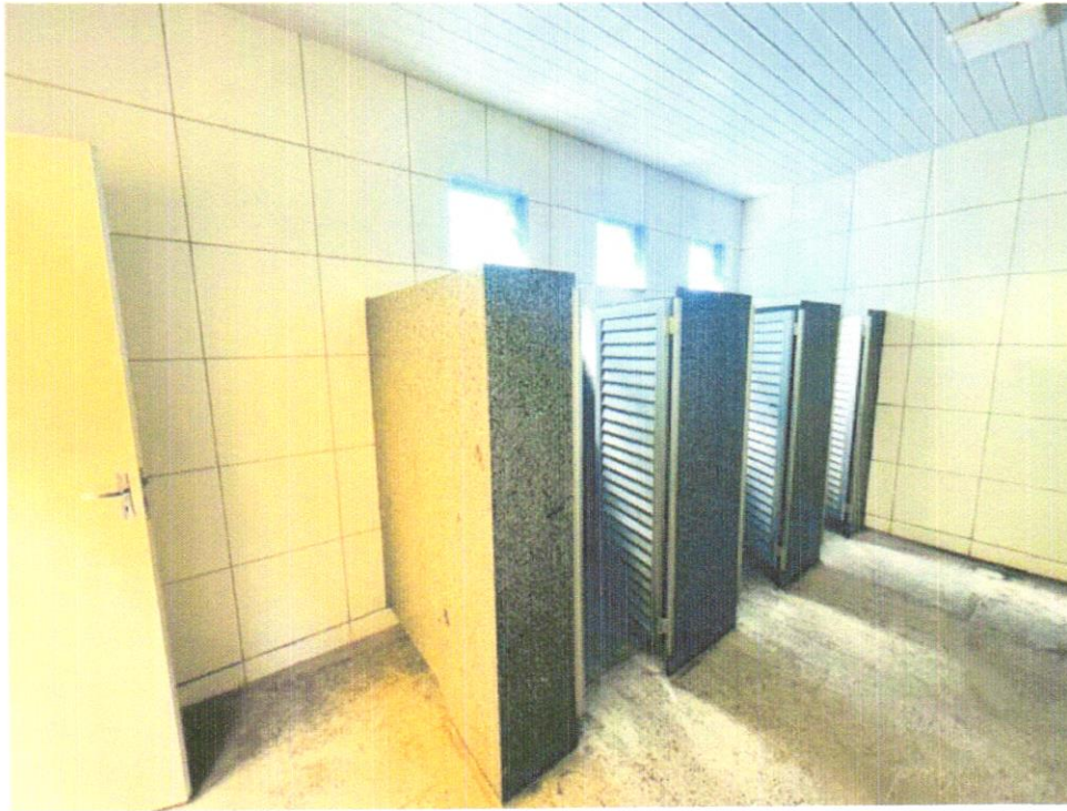
FOTO 06 – PORTA DE ABRIR EM ALUMÍNIO TIPO VENEZIANA, ACABAMENTO ANODIZADO NATURAL, SEM GUARNIÇÃO/ALIZAR/VISTA
