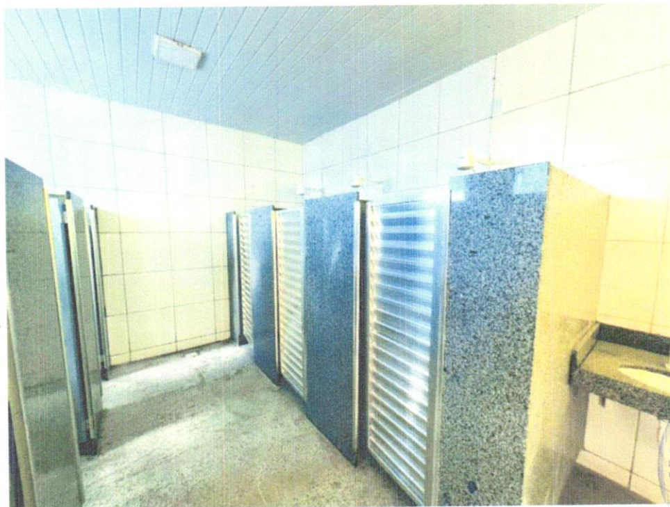
FOTO 06 – PORTA DE ABRIR EM ALUMÍNIO TIPO VENEZIANA, ACABAMENTO ANODIZADO NATURAL, SEM GUARNIÇÃO/ALIZAR/VISTA
